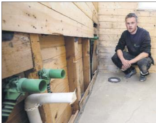
FORSKTIG. Rørlegger Bjørnar Meek sier at selv ikke fagfolk vet hva som skjuler seg bak veggen på badet. Derfor må man forsøke å få vite mest mulig om huset før man kan anslå kostnadene ved en oppussing.
